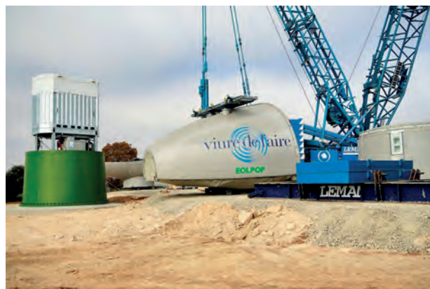
Base i carcassa de l'aerogenerador.
