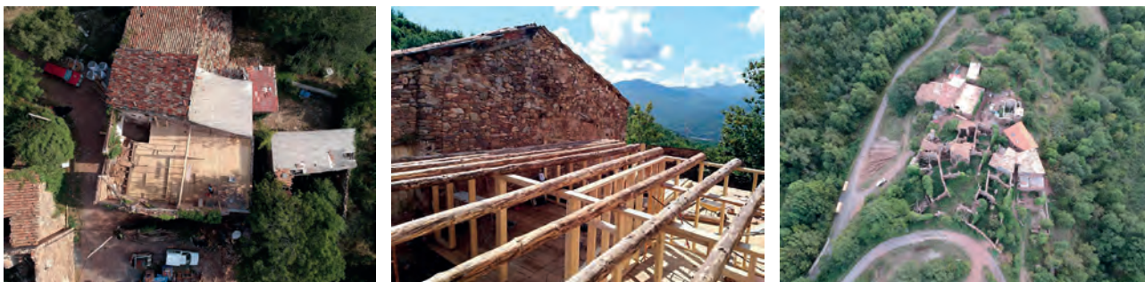
Rehabilitació dels edificis del poble.
